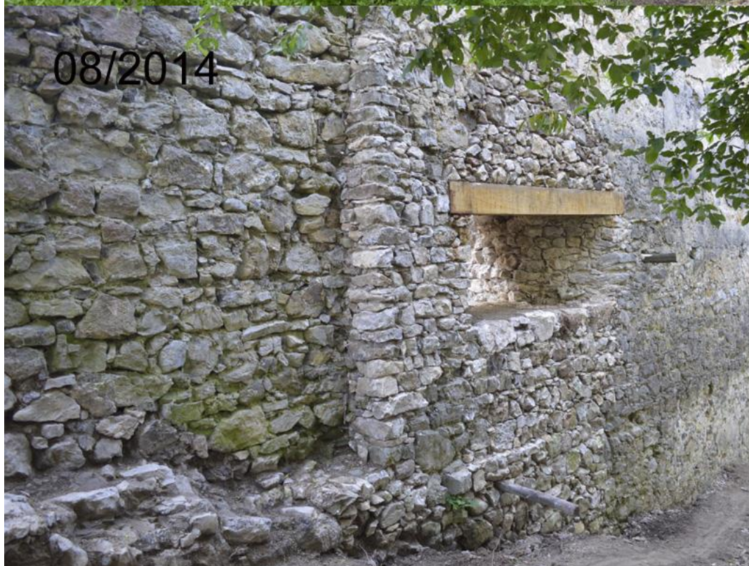
Druhá strana rovnakej steny (SZ stena budovy prvej brány), rekonštruované dve delové strielne.
