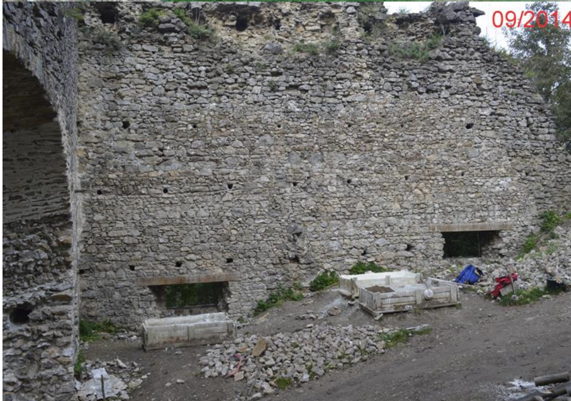
Zrekonštruovalo sa lice SZ steny budovy prvej brány. Rovnako sa zrekonštruovali dve delové strieľne.
