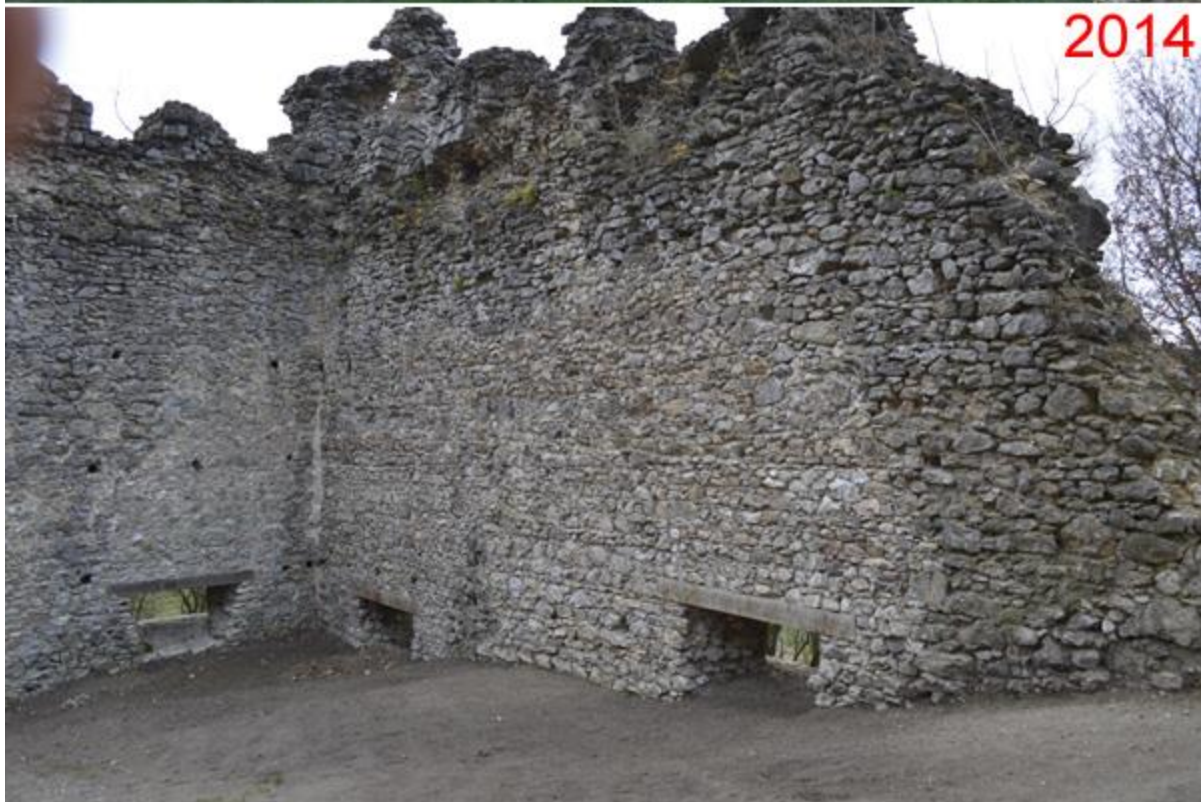
Zrekonštruovalo sa lice SZ steny budovy prvej brány. Rovnako sa zrekonštruovali dve delové strieľne.
