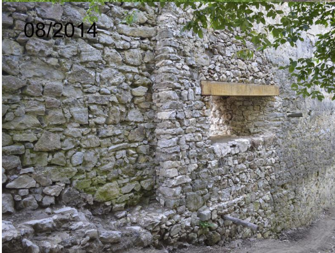
Druhá strana rovnakej steny (SZ stena budovy prvej brány), rekonštruované dve delové strieľne.
